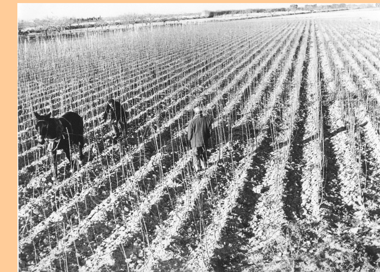
Trabajos sobre regadío
