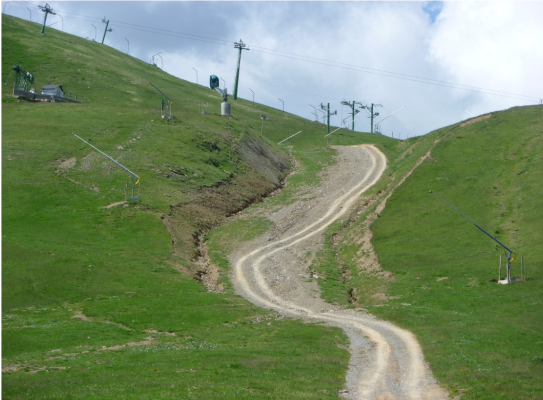
Restauración de la vegetación y resiembras a ambos lados de la pista
