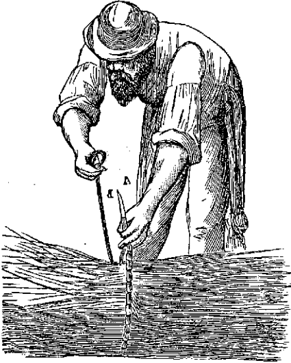
Figura 178.—Acto de pasar la aguja el obrero por la lazada del extremo opuesto del ramal
