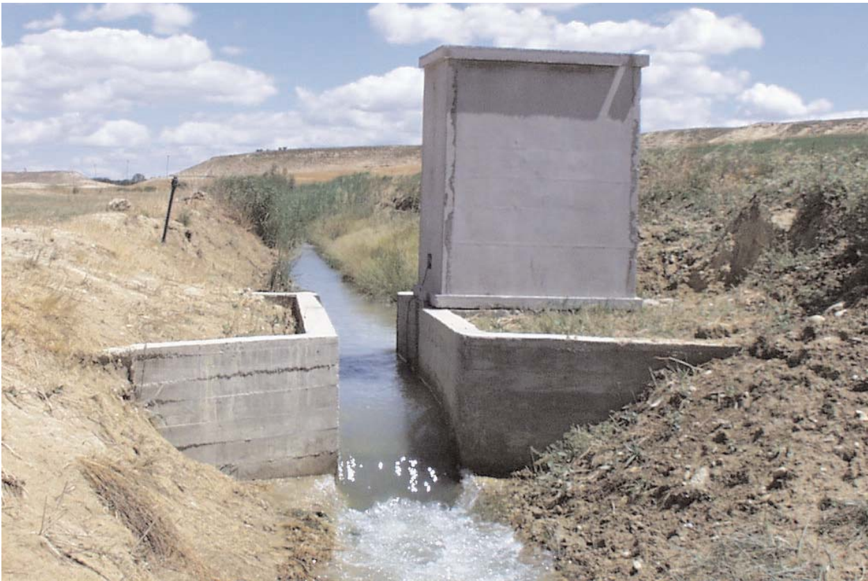
Estación para el control del caudal y calidad de aguas en un desagüe agrícola
