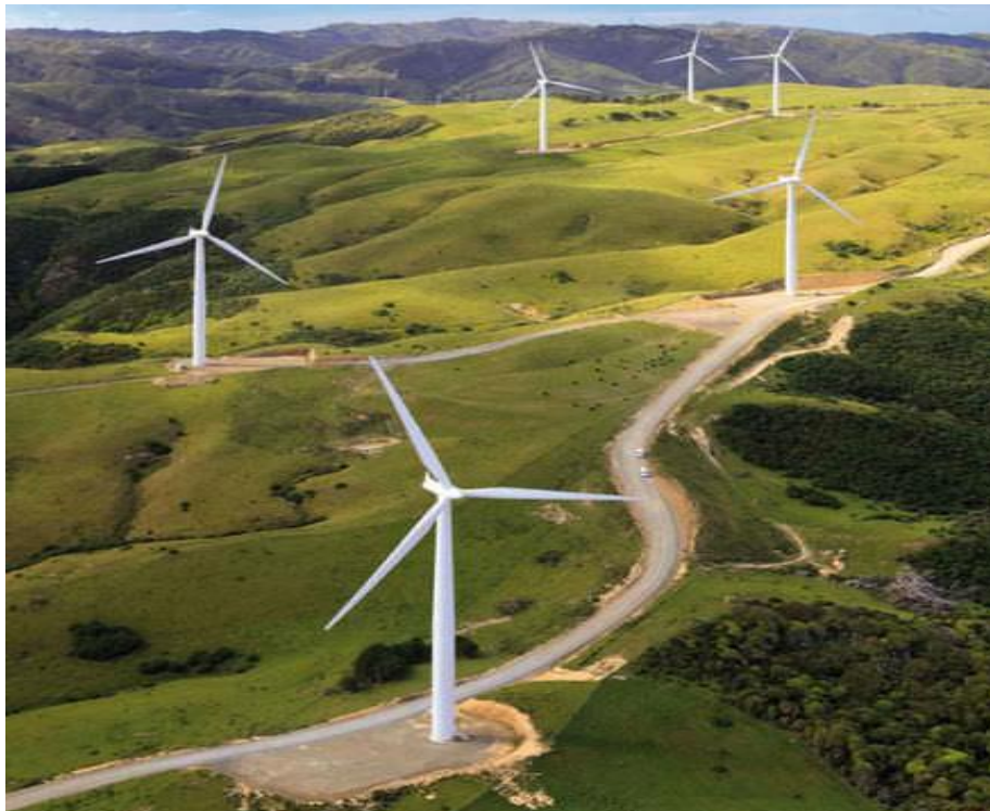
Figura 5. Aerogenerador de eje horizontal de tres palas (12)
