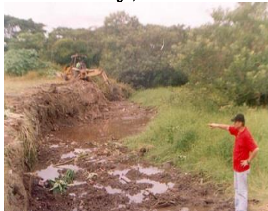
Ilustración 5. Extracción de escombros por exigencia de la comunidad a EEPP de Cartago, año 2004
