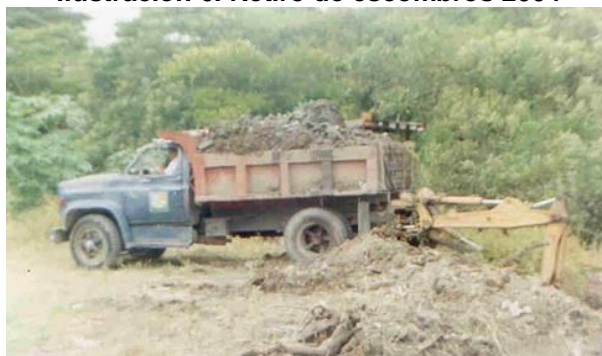
Ilustración 6. Retiro de escombros 2004
