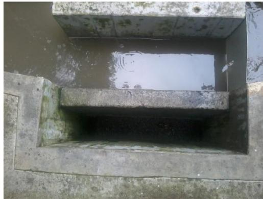
**FOTOGRAFIA 1.** Tanque desarenado
