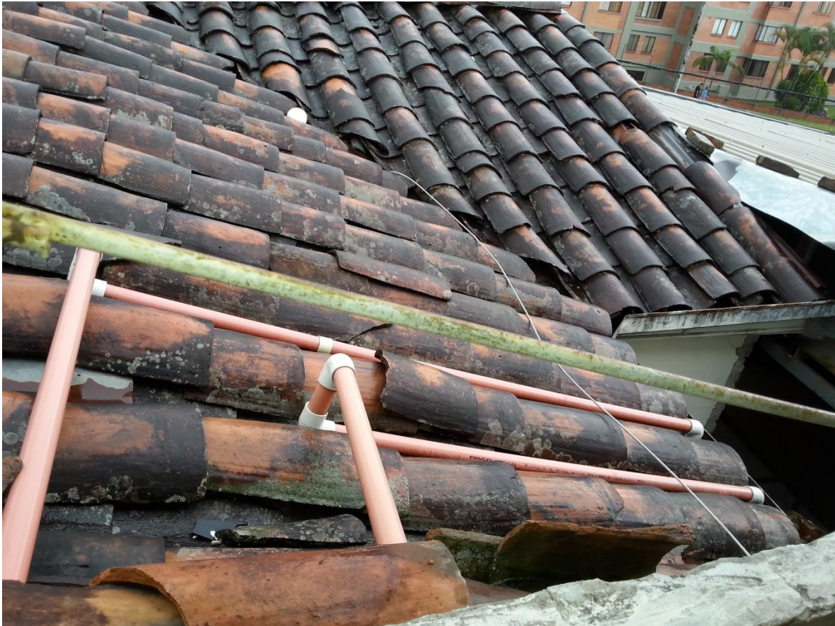
Figura 23. Sistema de drenado
