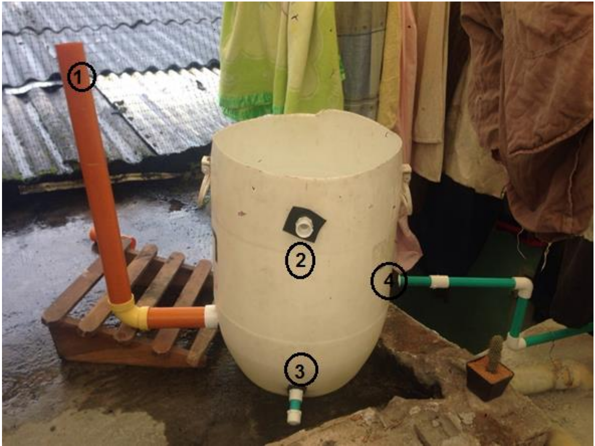
Figura 40. Tanque de almacenamiento y descripción de componentes
