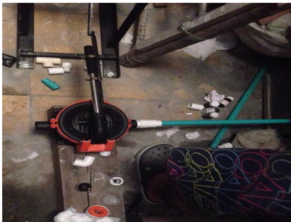
Figura 32. Fase inicial sistema de tuberías
