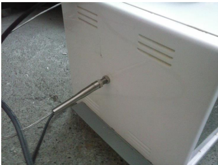
Figura 24 Instalación del sensor
