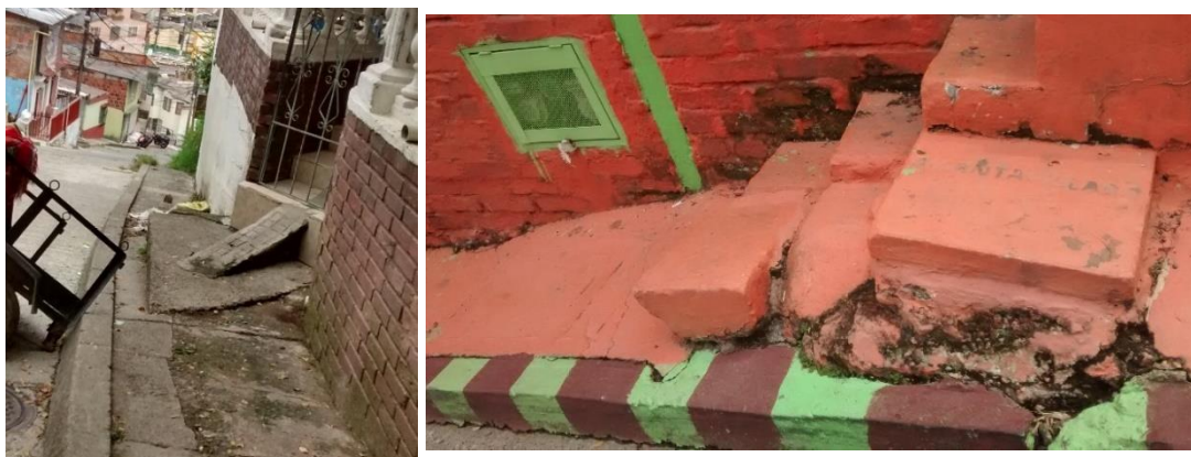
Fotografía 12 - Andenes de la Carrera 30 (El Tobogán)
