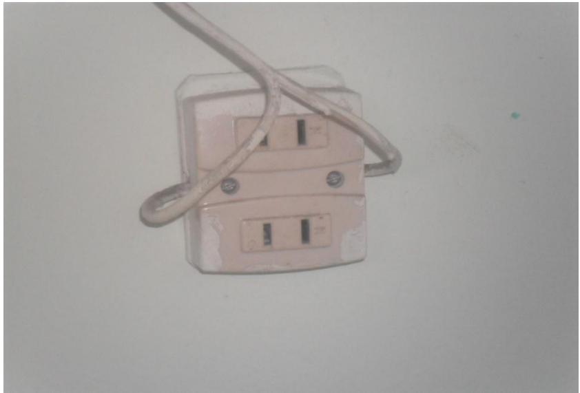
Ilustración 16 CONDUCTORES EXPUESTOS
