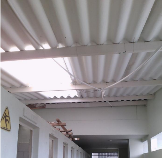
Ilustración 21 ILUMINACION EN BAÑOS
