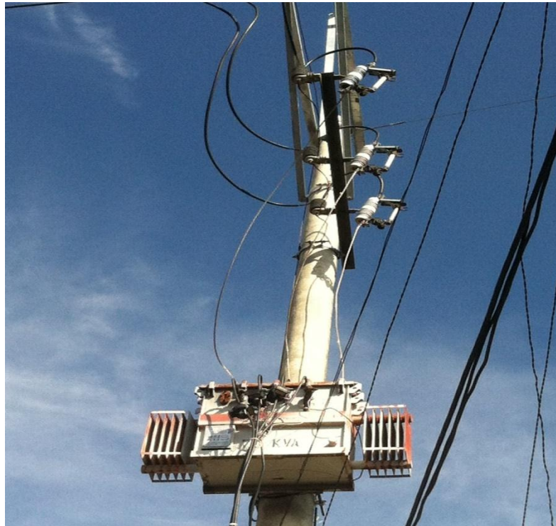
Ilustración 1 INSTALACION DEL DPS
