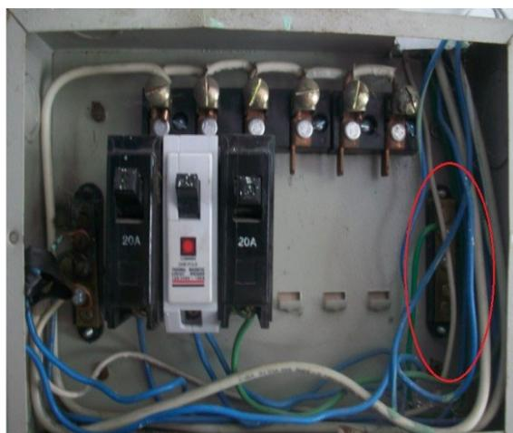
**Figura 33. Tablero principal descubierto**
