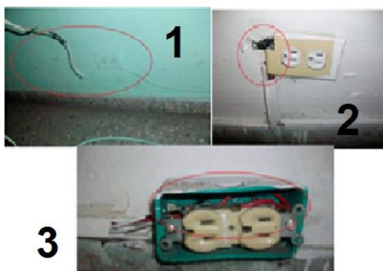
**Salida izquierda pasillo primer piso.** Se observa que hay un timbre puesto a la intemperie que tiene varios cables expuestos al medio ambiente, para esto se recomienda pasar el cableado por tuberías que puedan resistir el medio esto podría ser un riesgo para la red eléctrica y los equipos del colegio debido al agua lluvia. Ver **Figura 52**.
