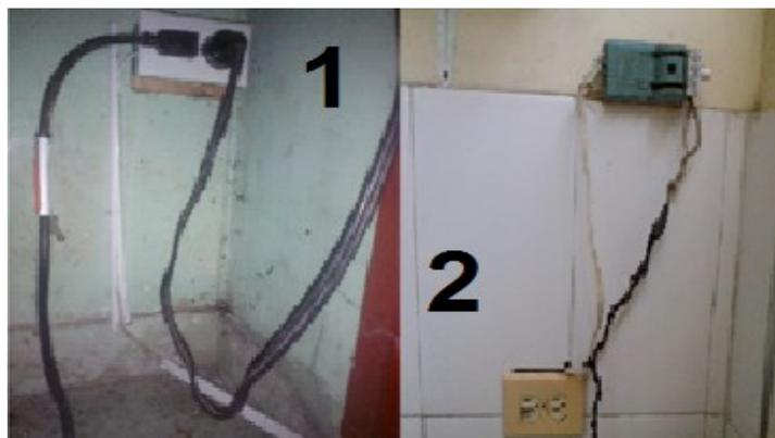
**Sistema de puesta a tierra de la institución.** Se observa que el conductor que va enterrado a la tierra física, tiene cierta inclinación que podría causar el rompimiento de dicho conductor.
