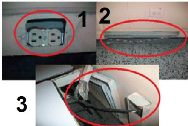
**Pasillos.** En los pasillos del colegio se pueden encontrar tuberías internas y externas de la estructura en mal estado con cableado expuesto.
