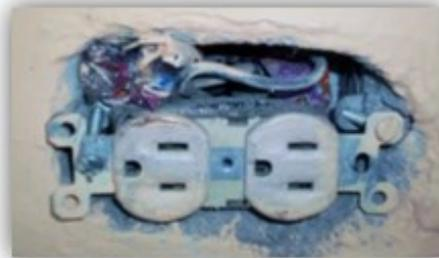
**Tomacorrientes en aulas de clases.** En varios salones de clases se encontraron tomacorrientes con diferentes fallas en su instalación (mal montaje), así: Ver **Figura 46.**
