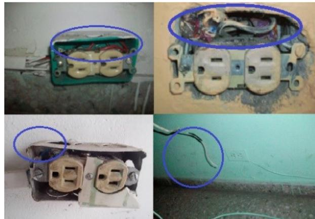
**Figura 48. Instalación eléctrica en mal estado.**
