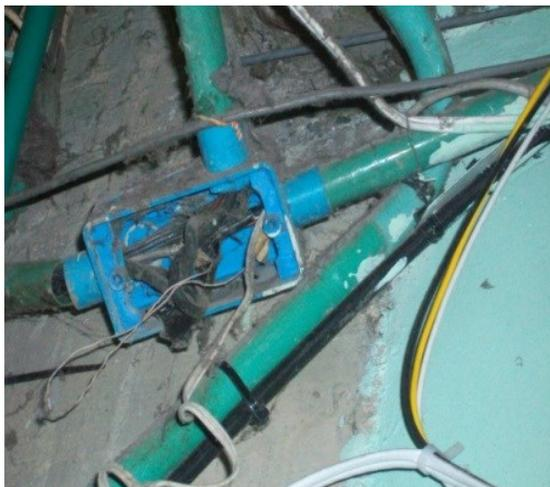
**Figura 44. Instalación eléctrica sin protección.**
