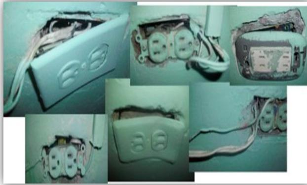
**Figura 47. Instalación eléctrica irregular.**
