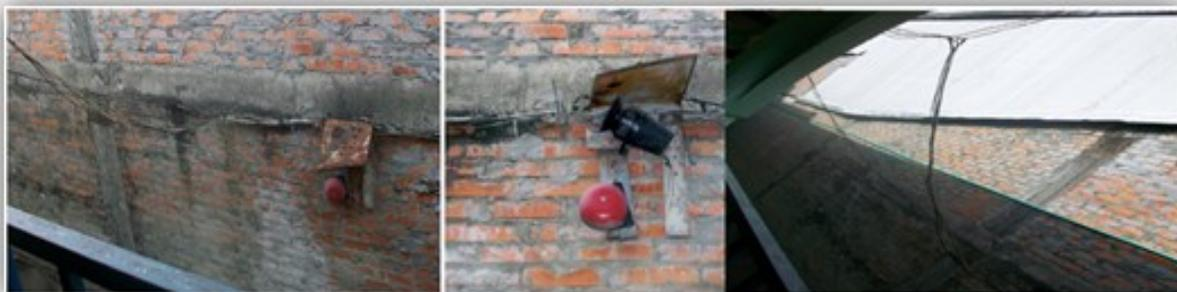
**Sala de sistemas.** Instalaciones en mal estado (falta de mantenimiento), en las canaletas se pueden observar los cables expuestos, también se puede ver que algunos tomacorrientes están desprendidos y exhiben sus cables energizados, el uso de extensiones multitomas sobrecarga del sistema. Ver **Figura 53**
