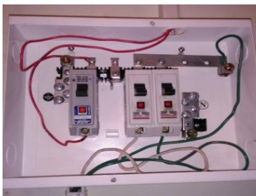
**Figura 36. Tablero sala de profesores descubierto.**
