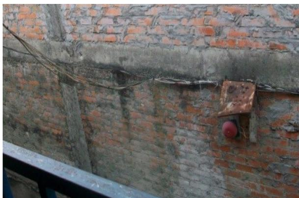
**Figura 45. Instalación eléctrica irregular.**
