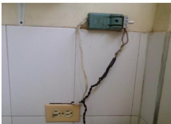
**Figura 46. Instalación eléctrica irregular.**
