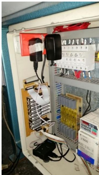
Figura 42. Posición Tarjetas de Control
