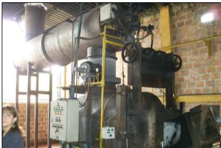
Figura 6. Sistema de Incineración de Residuos Hospitalarios y similares Empresa SALVI LTDA
