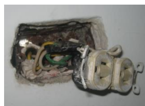
Figura 10. Toma N° 2 salón 1a piso 2.
