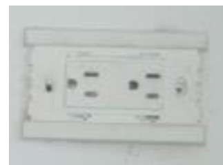
Figura 12. Toma N° 2 salón 5a piso 3
