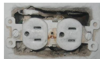
Figura 11. Toma N° 2 salón 2a piso 2.
