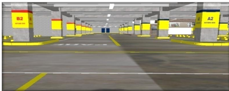
Figura 33 Vista previa del carril A2-B2 sótano.
