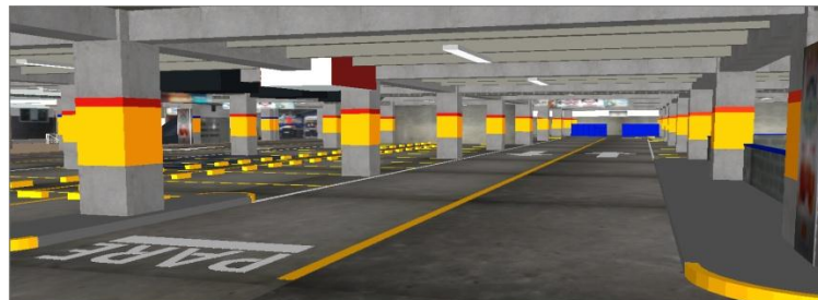
Figura 17 Vista previa del carril B1-C1 semisótano.
