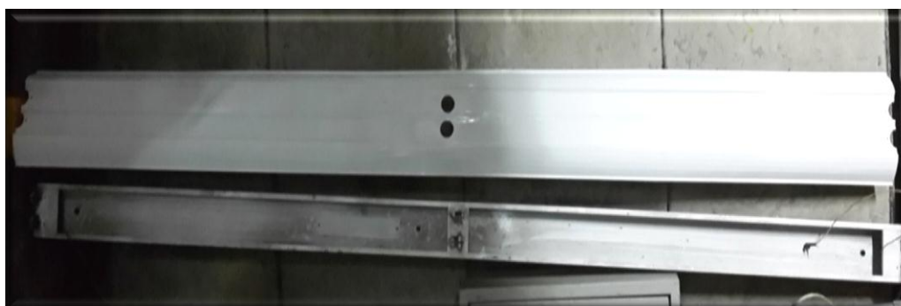
Figura 8 Parte interna de una luminaria para lámpara tubular fluorescente.
