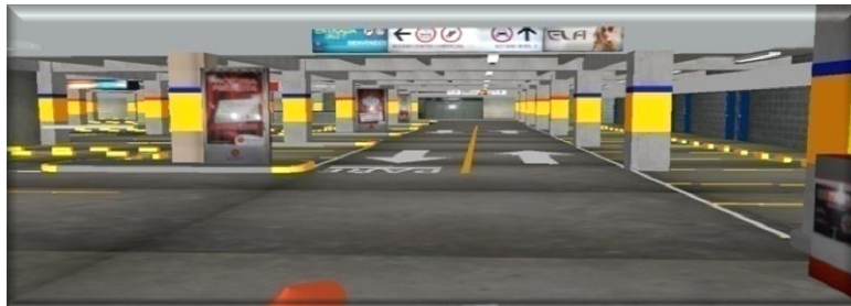
Figura 27 Vista previa del carril A1-D1 (este) semisótano.
