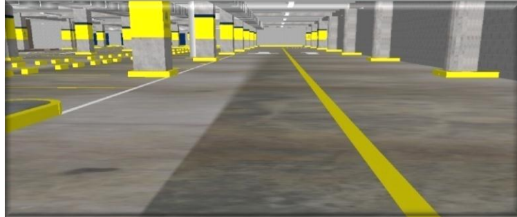
Figura 29 Vista previa del carril A2-A2 (Sur) sótano.
