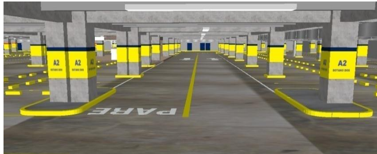
Figura 31 Vista previa del carril A2-A2 (Norte) sótano.
