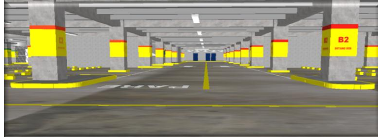
Figura 35 Vista previa del carril B2-C2 sótano.
