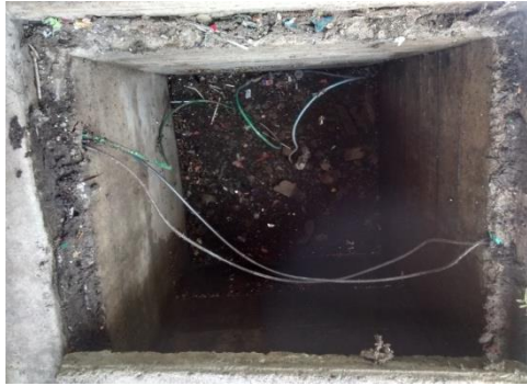
Figura 45. Electrodo de puesta a tierra
