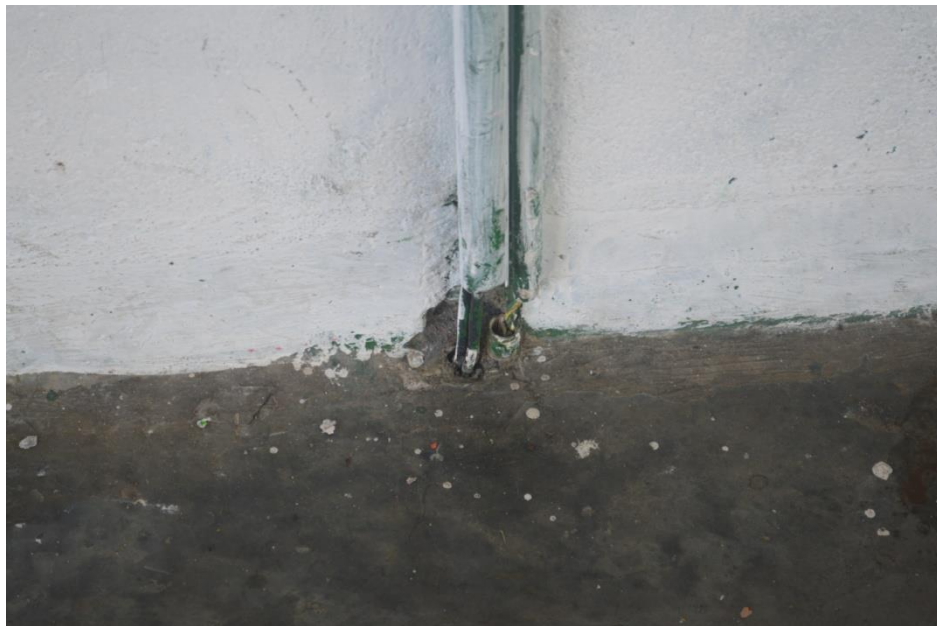
Figura 8. Línea de alimentación 2 instalaciones de canalización (artículo 318).
