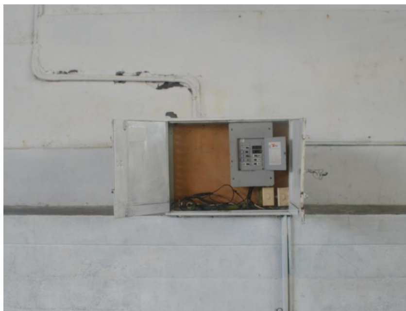
Figura 35. Caja de corte
