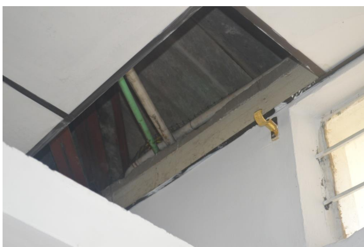
Figura 3. Entradas verticales con tubería PVC.
