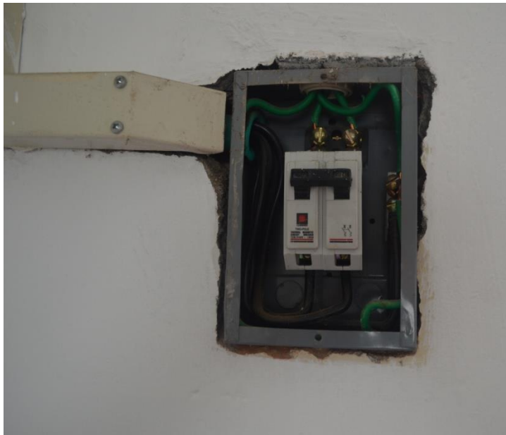
Figura 4. Canaleta metálica.
