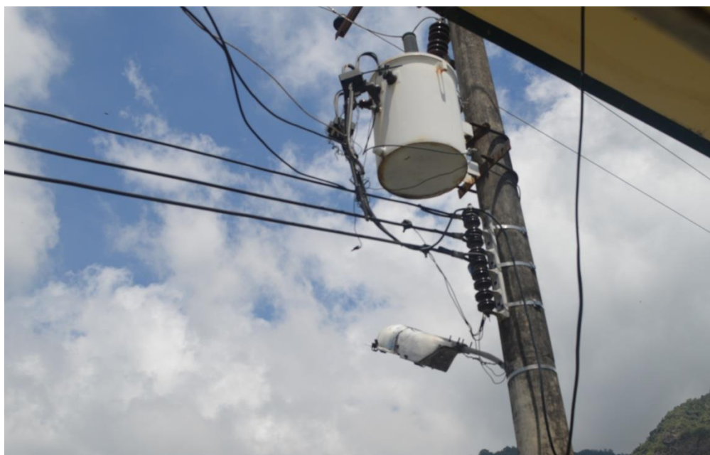
Figura 12. Conductores de acometida 1.
