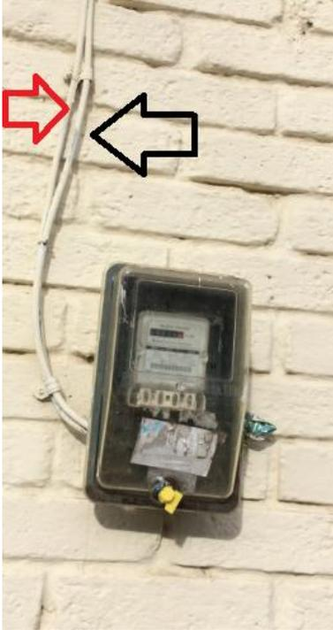
**Figura 177 Derivación de cable concéntrico a cable rígido.**
