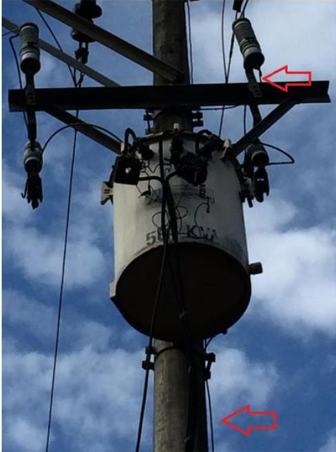
**Figura 11 Transformador de 50 KVA y sistema de puesta a tierra de las aulas 11 al 18 restaurante, CERES “matrícula # 2.**
