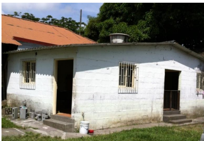
Figura 6. Vista general oficinas
