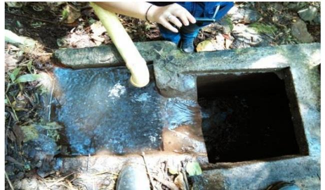
Fotografía 27. Cámara de entrada al desarenador.
