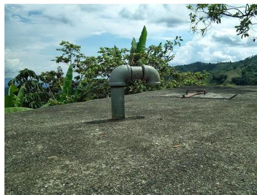
Fotografía 17. Tubería de ventilación, tanque de almacenamiento Vereda La Mancha.
