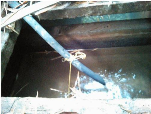
Fotografía 14. Sedimento en la entrada al desarenador.
