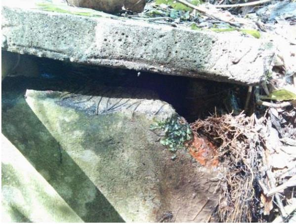
Fotografía 24. Orificio de excesos cámara de entrada.
