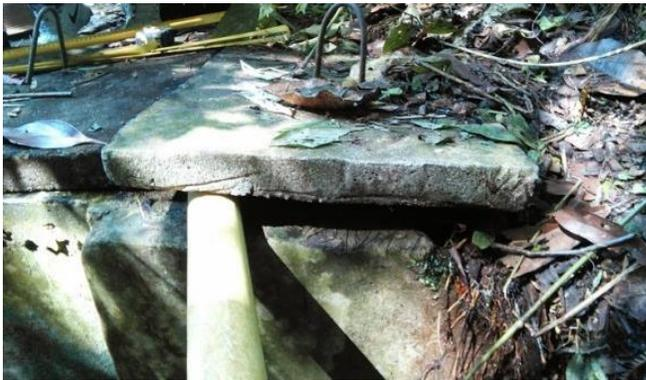
Fotografía 26. Entrada de la tubería de aducción a desarenador.
