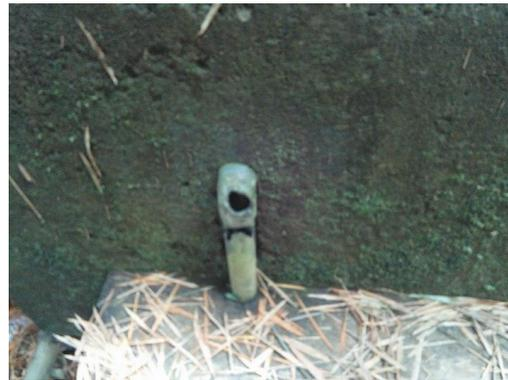
Fotografía 15. Degaste y filtración lateral del desarenador.
