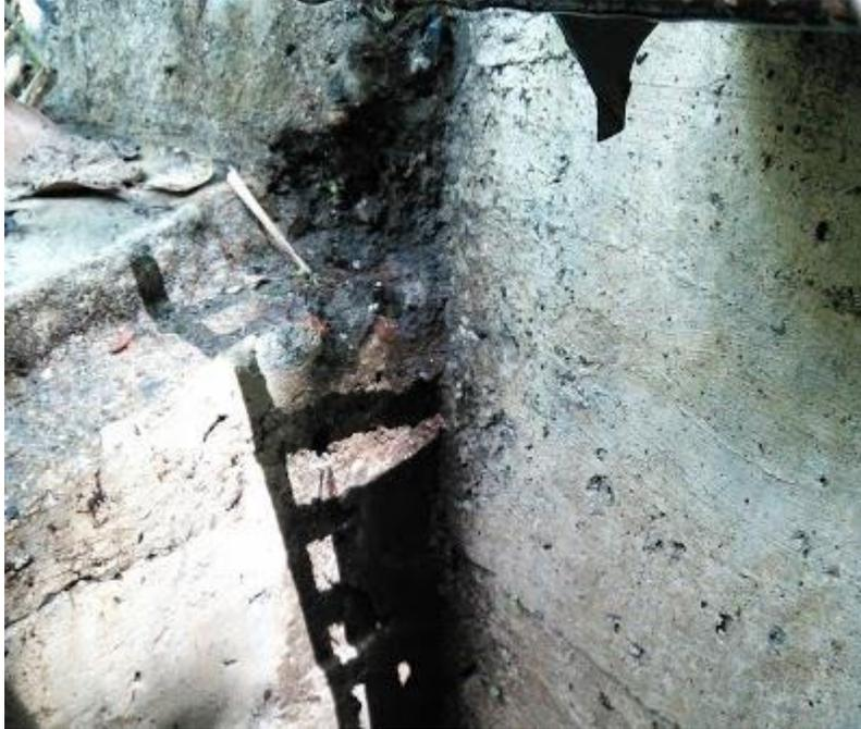
**Fotografía 23.** Desgaste canal rectangular
