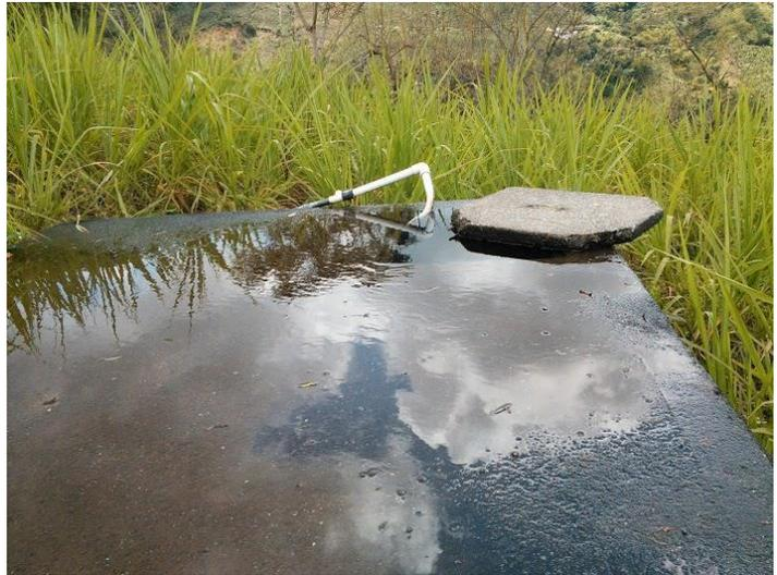
Fotografía 31. Tubería de ventilación del tanque de almacenamiento.
