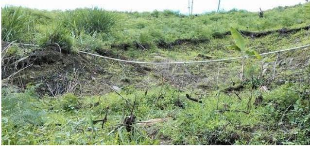
Fotografía 28. Tramo colgado de la tubería de conducción.
