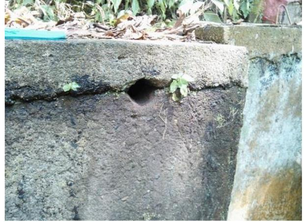
Fotografía 25. Orificio de excesos cámara de salida.
