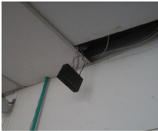
Figura 41. Cableado en mal estado.
