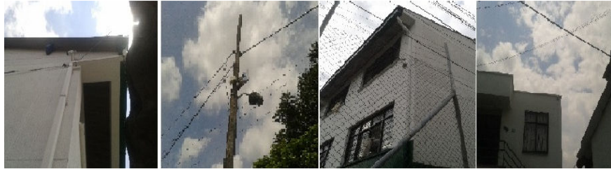
Figura 50. Cámaras de vigilancia.
