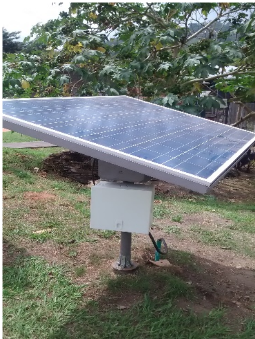
Figura 78. Panel solar de 300w 24v dc
