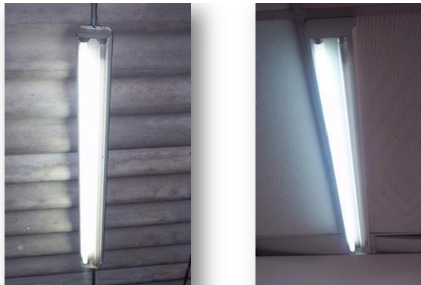
Figura 48 luminarias con una lámpara mala [5]
