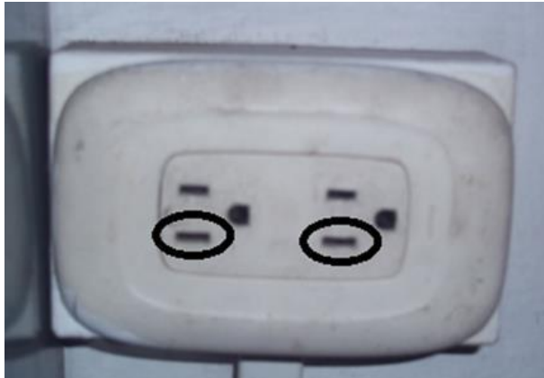
Figura 27 Posición incorrecta del neutro [5]
