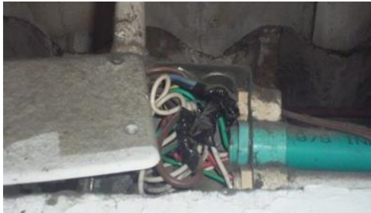
Figura 28 Caja de paso [5]
