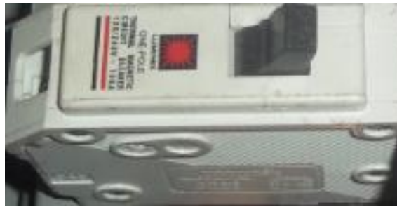
Figura 20 Placa de accionamiento del Interruptor [5]
