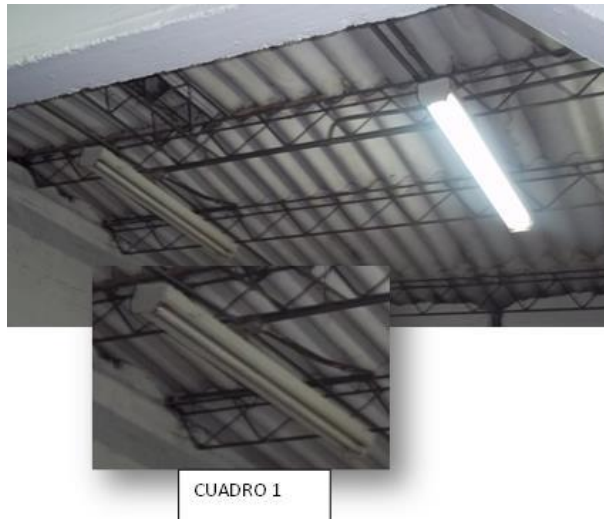
Figura 48 luminarias con una lámpara mala [5]
