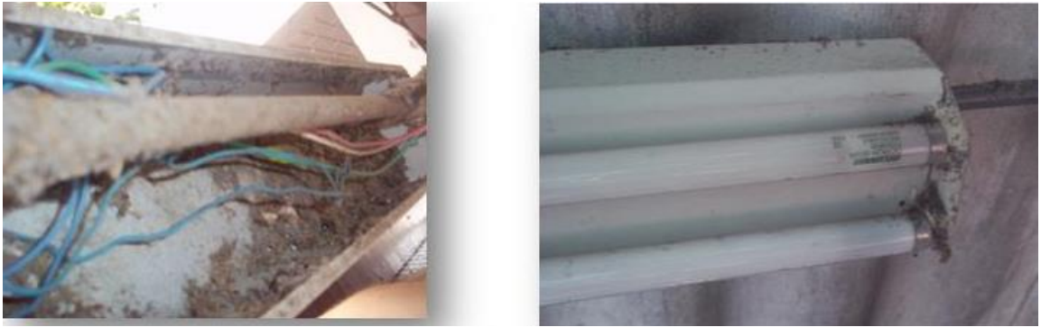
Figura 49 Lámpara sucia [5]
