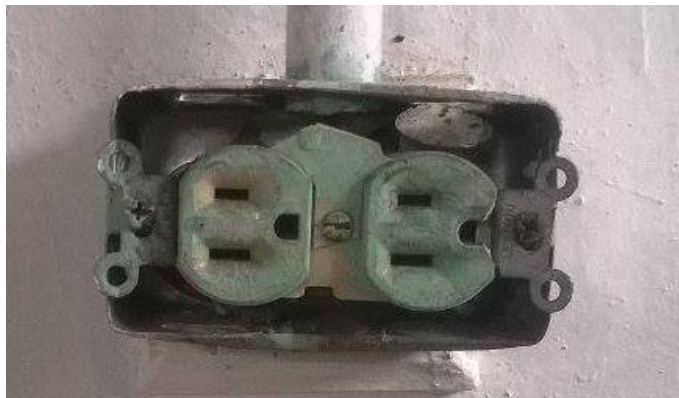
Figura 26 Tomacorriente inadecuado. [6]
