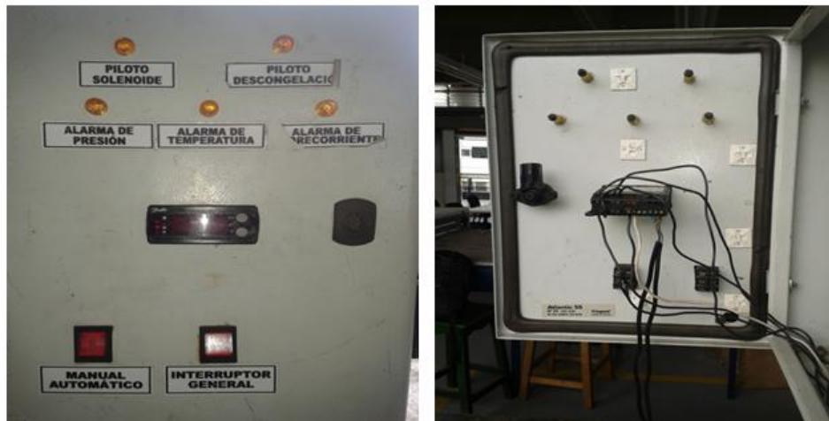
Figura 11 Controlador EKC 100 Danfoss
