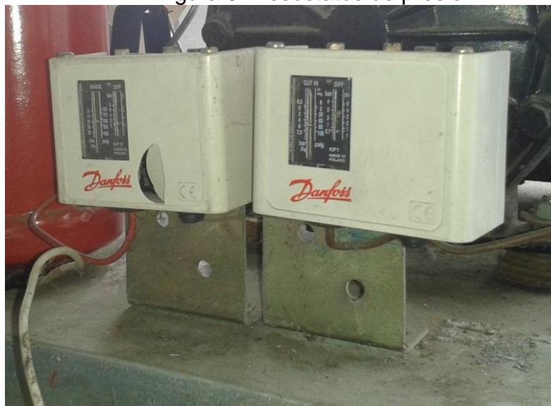
Figura 6 Presostatos de presión
