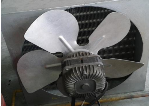
Figura 4 Motor ventilador condensadora
