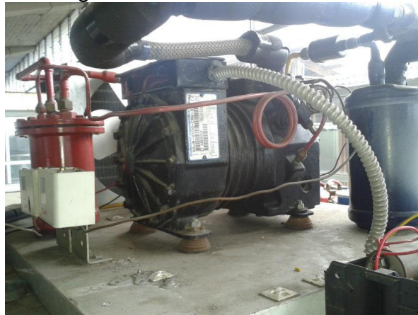
Figura 2 Unidad condensadora
