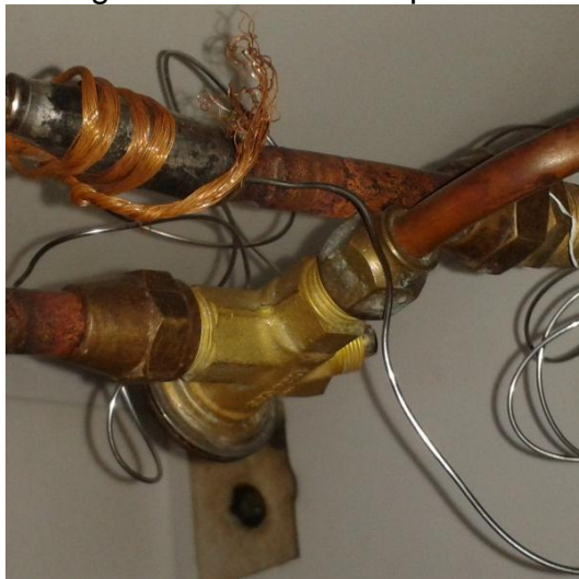
Figura 9 Válvula de expansión
