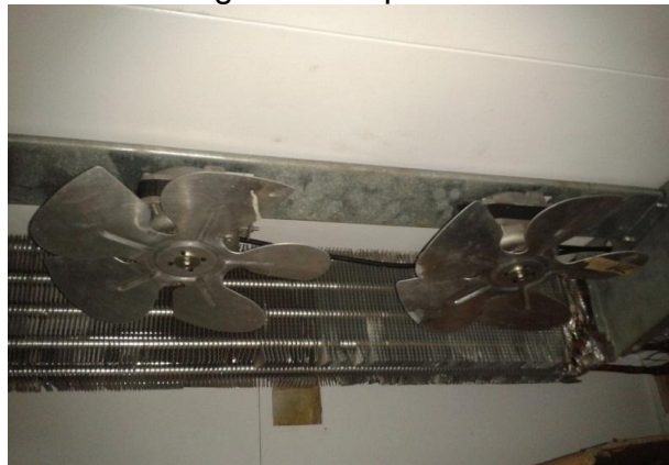
Figura 3 Evaporador
