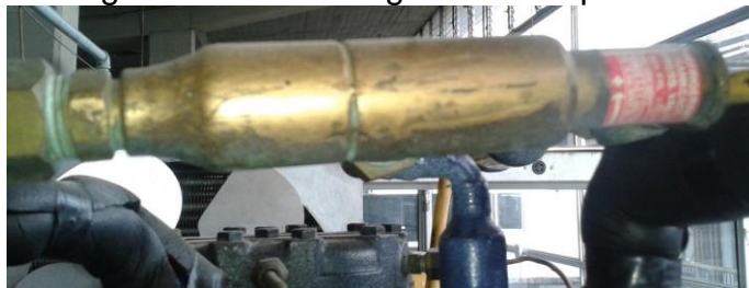
Figura 10 Válvula reguladora de presión
