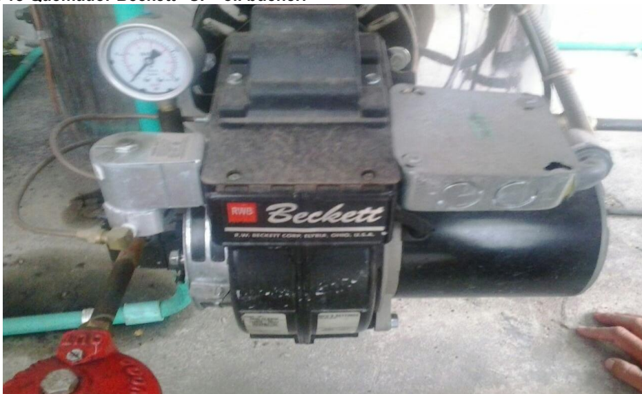
Ilustración 13 Quemador Beckett "SF" oil buener.
