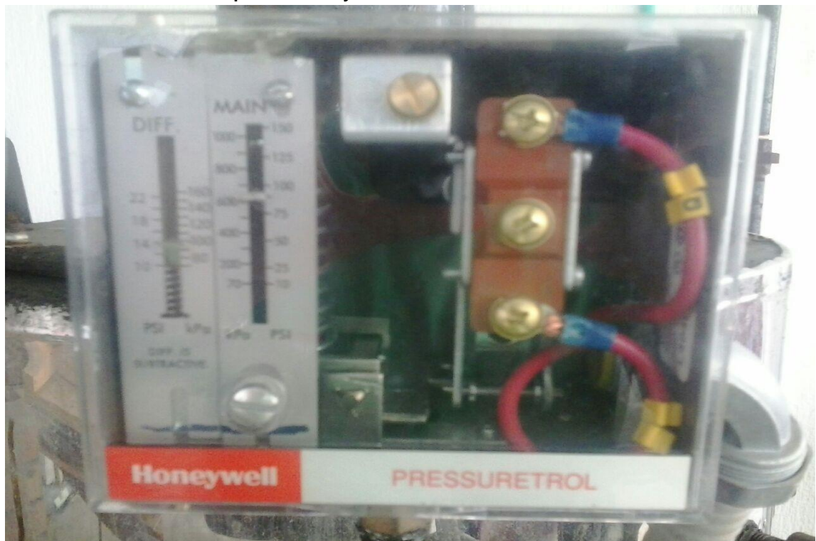
Ilustración 14 Controlador de presión Honeywell L404F1102.
