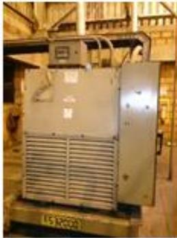
9. Pasar a **0** todas las perillas de los pasos automáticos Bancos de Condensadores y solicitar al electricista de turno que saque los demás bancos de condensadores de los otros circuitos de fábrica.
