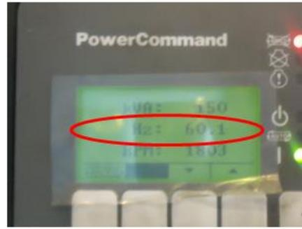
Este resultado indica que el funcionamiento del equipo es el óptimo para la programación, conexión y configuración del equipo para la variable de frecuencia.
