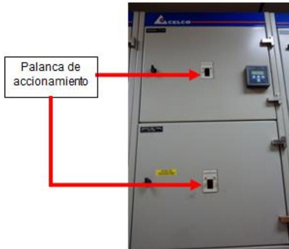
Para abrir los interruptores CUTLER HAMMER (INT. GENERAL BCO CONDENSADORES, INT. GENERAL SALA COMPRESORES, INT. GENERAL TBLERO ALUMBRADO, RED CONTRA INCENDIOS DESTILERIA, ALUMBRADO DESTILERIA) se debe presionar el boton **PUSH OFF** y verificar que la indicacion pase de Cerrado (**CLOSED**) a Abierto (**OPEN**).
