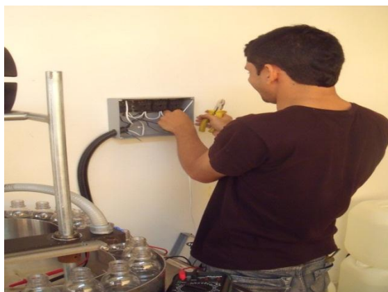
Figura 64 Montaje del nuevo sistema eléctrico.
