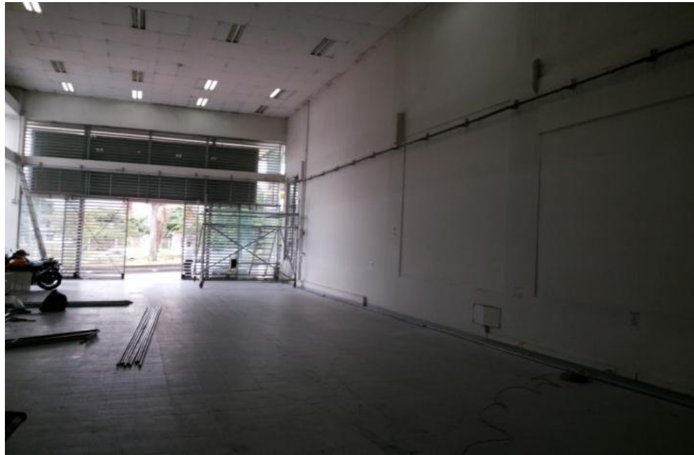
Figura 19. Vista general bodega
