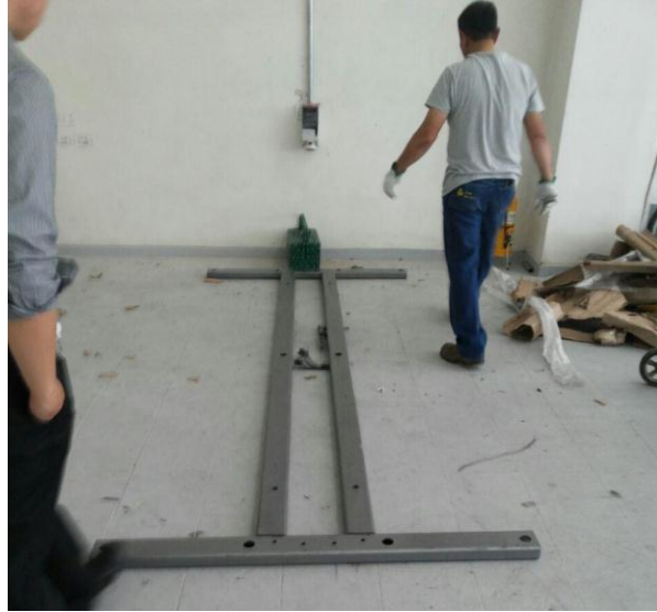
Figura 22. Instalación Elevador Dos Columnas 1
