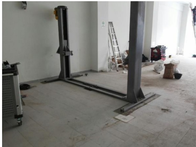
Figura 23. Instalación elevador dos columnas 2
