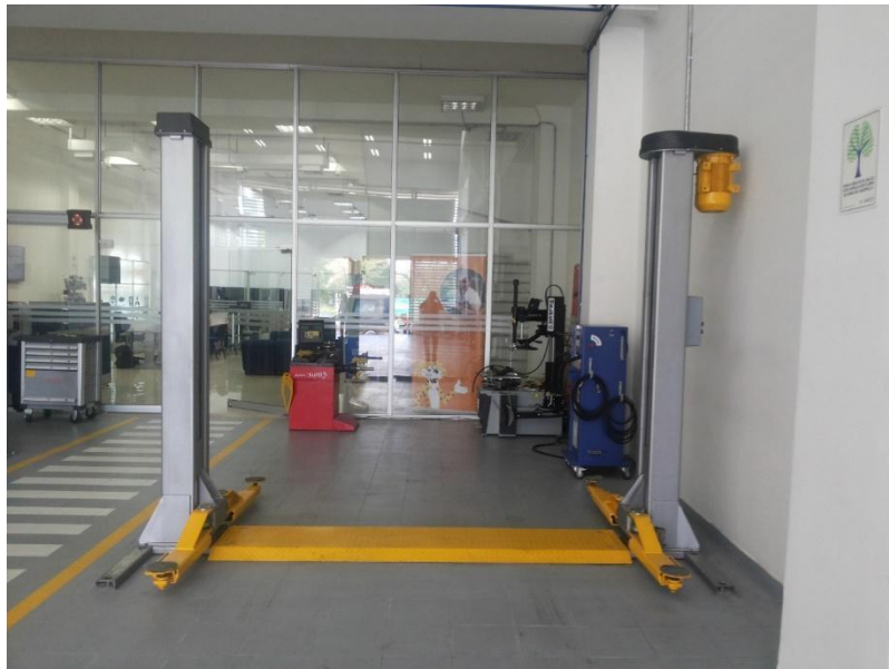
Figura 29. Instalación Final Elevador 2 Columnas
