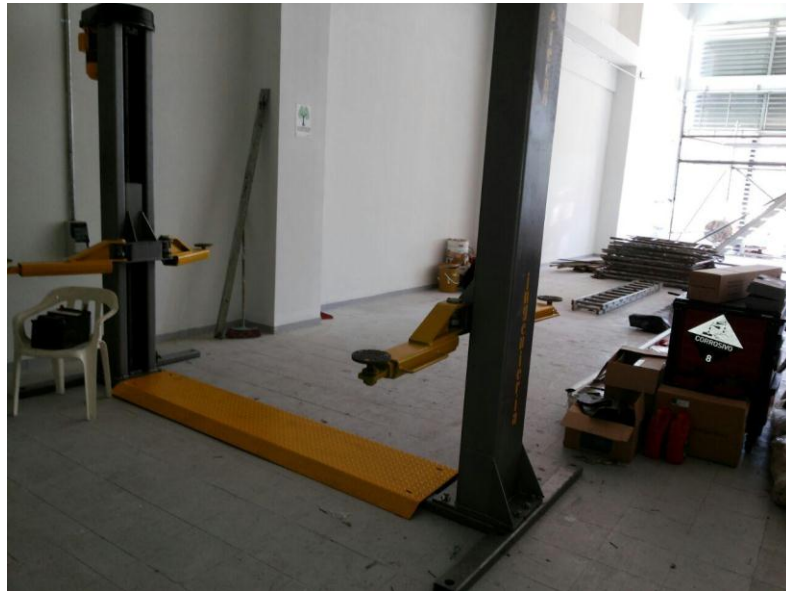
Figura 24. Instalación elevador dos columnas 3
