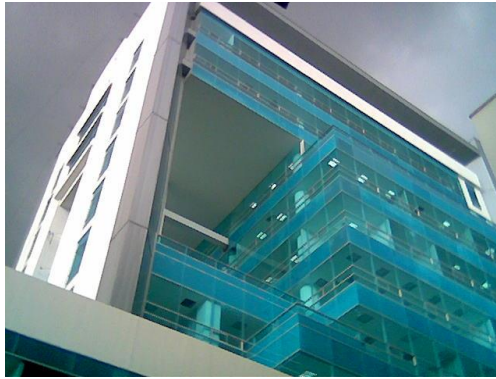
Figura 1: Edificio torre central Pereira, Risaralda
