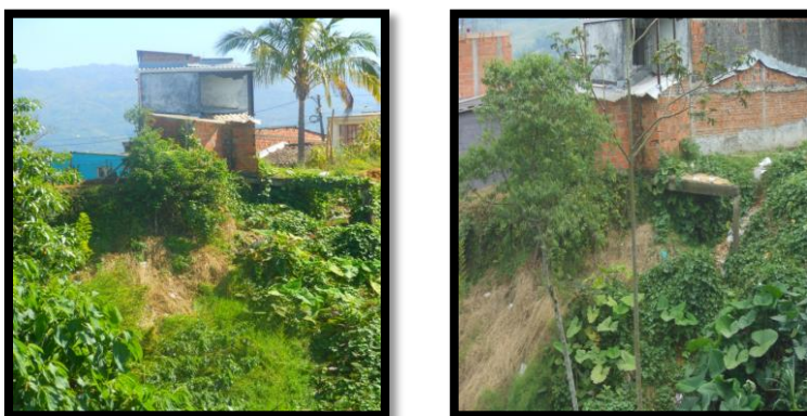
Figura 30. Viviendas en Condición de Riesgo.
