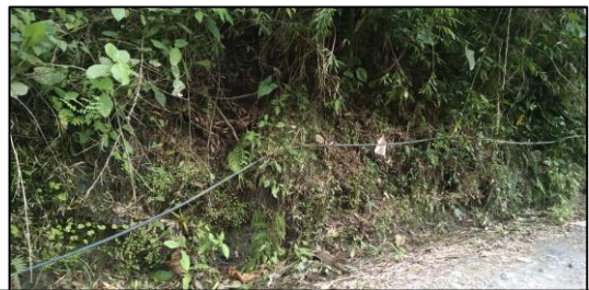
Foto 3 Mangueras de conducción del agua
