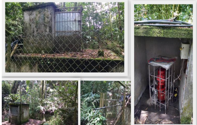
Foto 6 Collage infraestructura acueducto Colmenas Bajo
