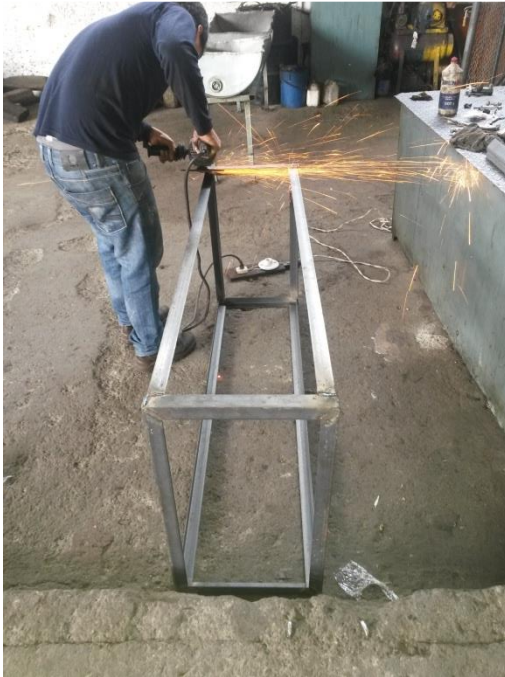
Figura 134. Construcción de la estructura
