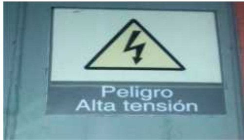
Figura22. Señalización de seguridad tablero primer piso
