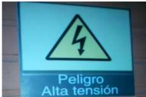
Figura23. Señalización de seguridad tercer tablero segundo piso
