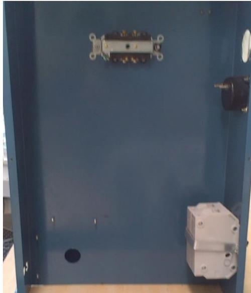
Se tuvo que hacer una nueva perforación para el segundo medidor, así como para la instalación de los porta fusibles.
