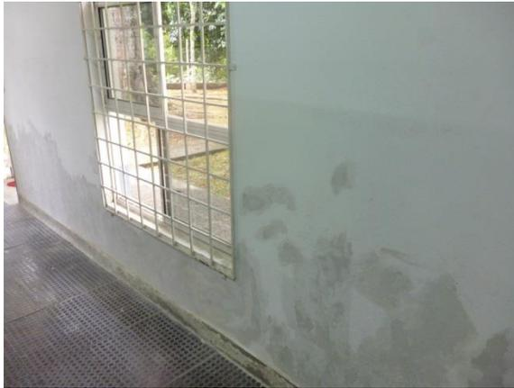
Al ver lo que sucedía en las paredes del laboratorio se rasparon y se limpiaron para después resanarlas, pintarlas y comenzar el nuevo montaje. Después de estar resanadas y pintadas se comienza el desmontaje de la iluminación donde se tuvo que hacer el mismo proceso de las paredes en el techo.
