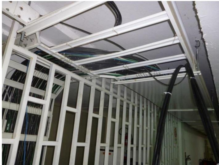
Como se observa en la imagen en la parte izquierda todos esos cables están saliendo de la subestación y son transportados por la bandejas hasta llegar a los tableros de distribución.
