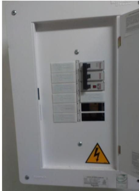
En esta figura se observa el breaker trifásico el cual alimenta el centro de control para el compresor, dicho compresor es utilizado para los mecanismos neumáticos.
