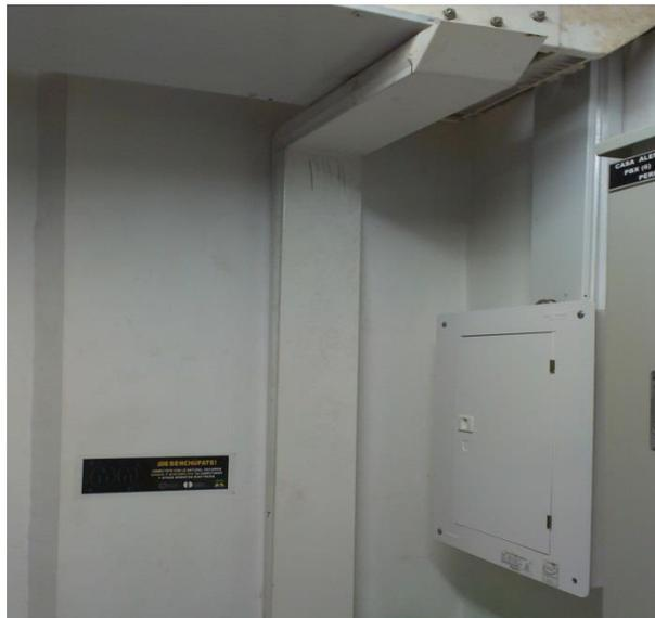
En la figura 34 se puede observar ya instalado el nuevo tablero trifásico en el laboratorio de relevación y control.
