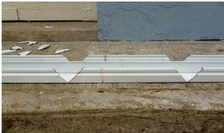
Después de hacer y comprobar que todos los cortes de las canaletas quedaron bien, se procedió a montar todas las canaletas y el tablero de distribución.
