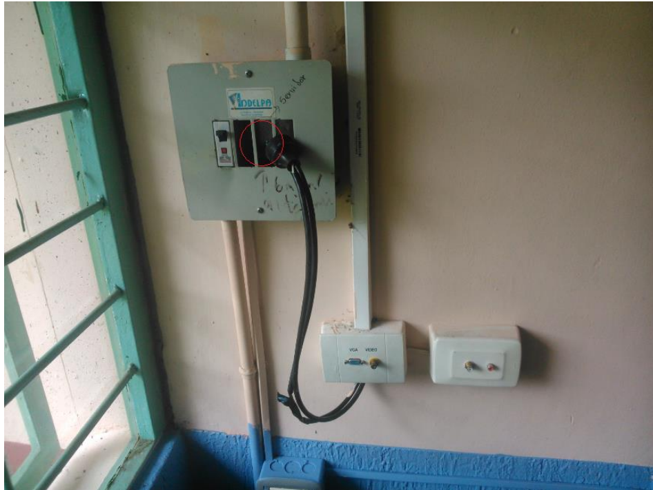
Figura 16. Tablero descubierto
