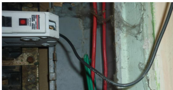
Figura 49. Conductor apropiado para la protección
