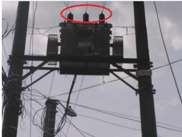
Figura 27. Buges de transformador
