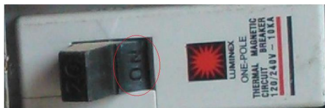
Figura 39 Placa de accionamiento del Interruptor
