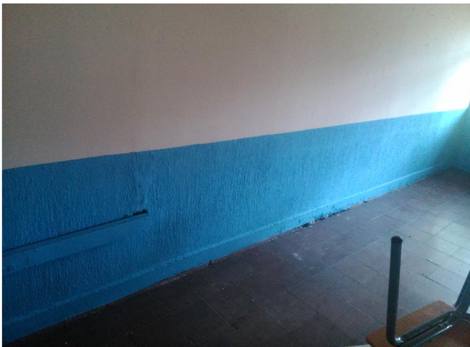
Figura 20. Espacio mayor a 1.8m para toma eléctrico
