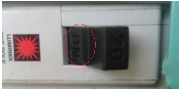
Figura 35. Placa de accionamiento del Interruptor
