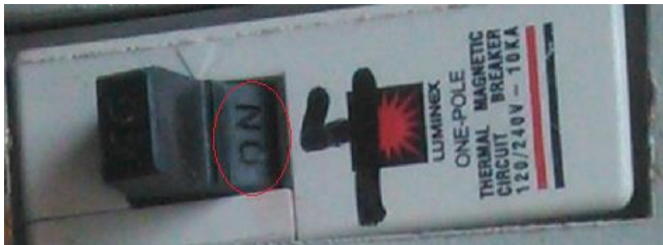
Figura 37. Placa de accionamiento del Interruptor
