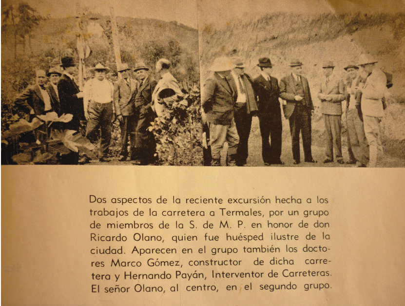
Ilustración 35. Señor Ricardo Olano en compañía de los miembros de la SMPM, observando el trazado de la carretera que conduciría a los termales del Ruíz, 1939.
