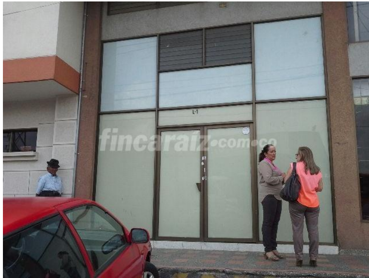
Imagen 15: Local Los Molinos Dosquebrada 1
