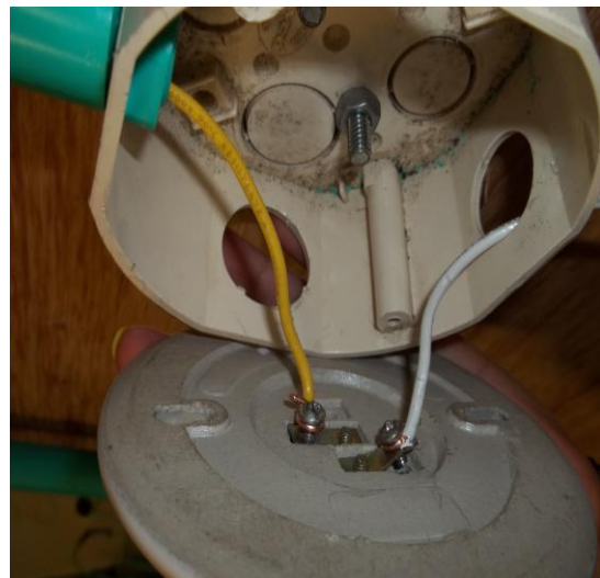
Figura 103 Conexión salida de iluminación
