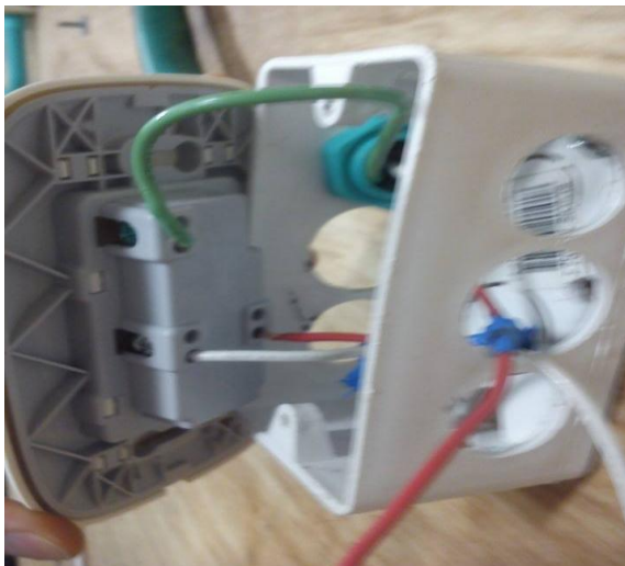
Figura 87 Conexión de salida de fuerza
