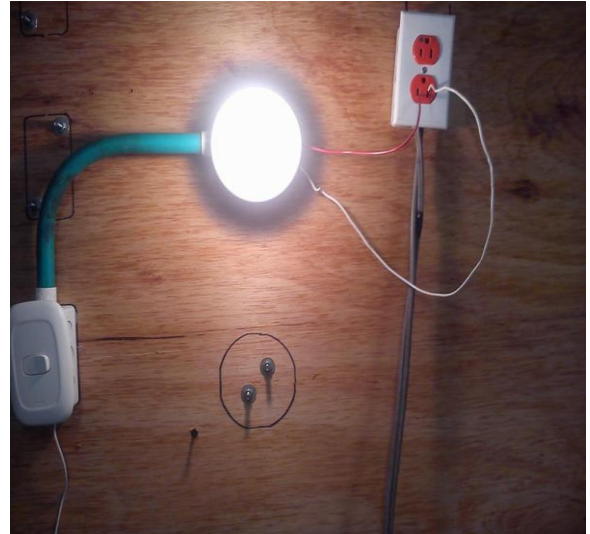
Figura 78 Salida de iluminación del interruptor sencillo
