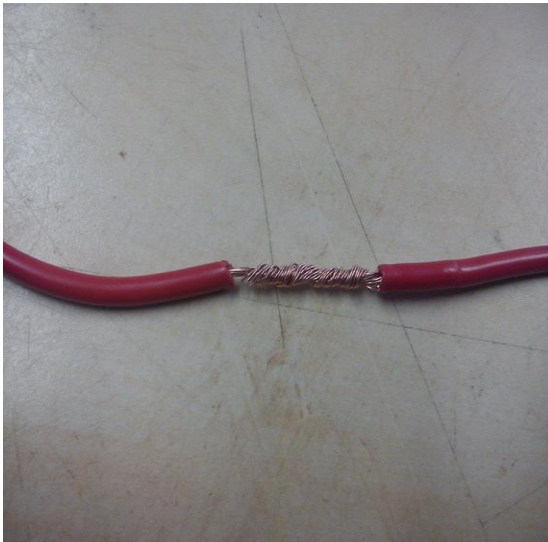
Figura 65 Empalme por prolongación
