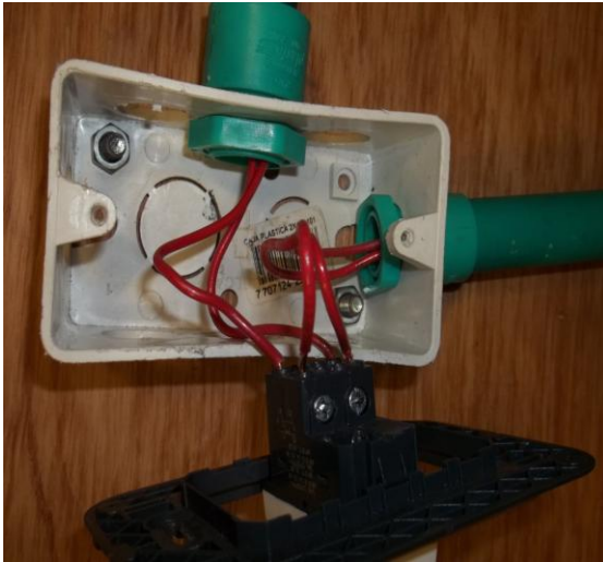
Figura 106 Conexión interruptor de cuatro vías
