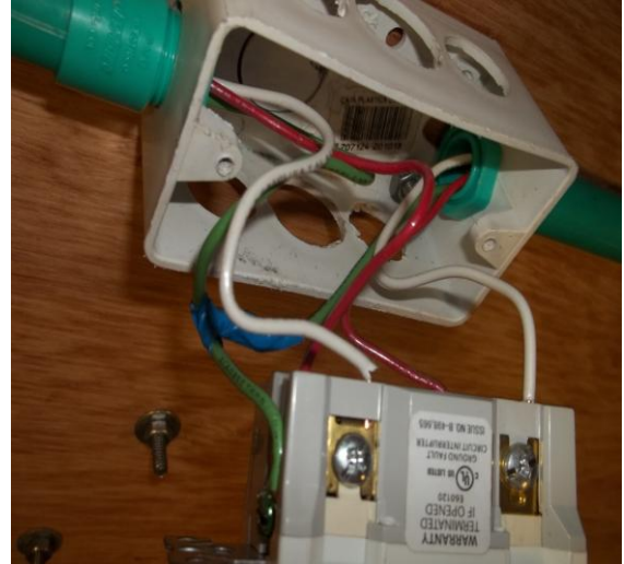
Figura 112 Conexión del tomacorriente GFCI
