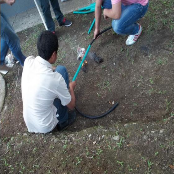
Figura 75 Calentamiento de la tubería
