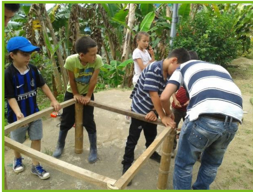
Fotografía 8. Participación en la construcción del sistema ecológico, escuela La Florida
