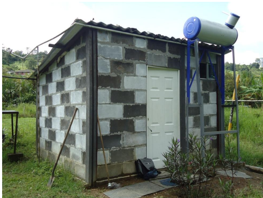
Figura 31. Montaje final del calentador solar (vista trasera).
