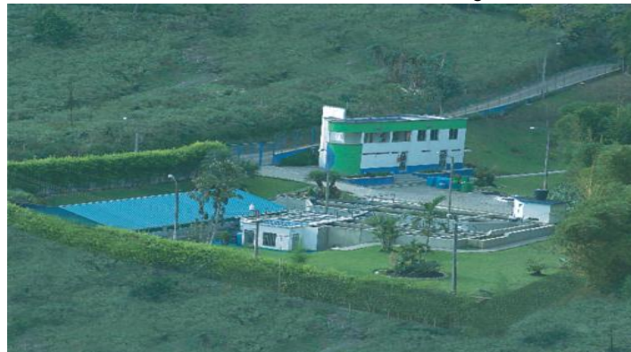
Ilustración 3. Planta de tratamiento Aguazul
