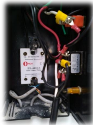
Figura 36. SSR instalado en caja de proyecto con conexiones.
