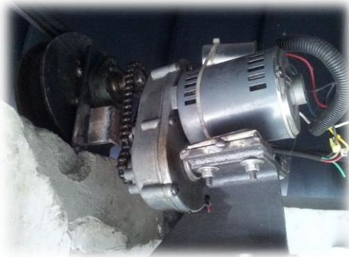
Figura 1. Motor que genera el movimiento del domo
