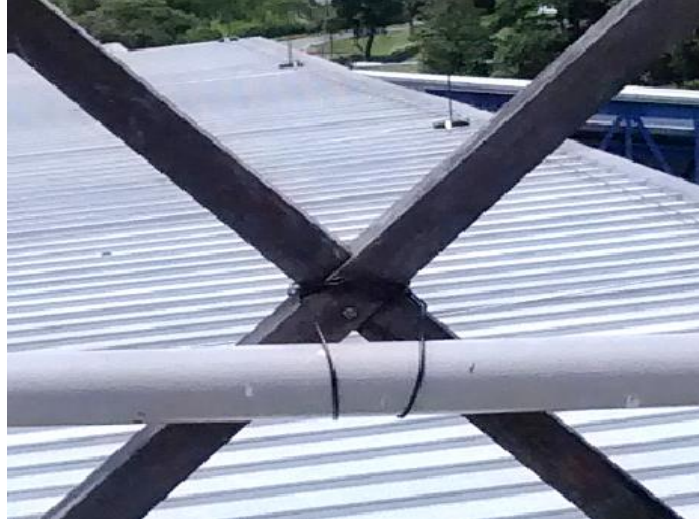
Figura 22. Empalme de los perfiles de madera para el armado de la antena.
