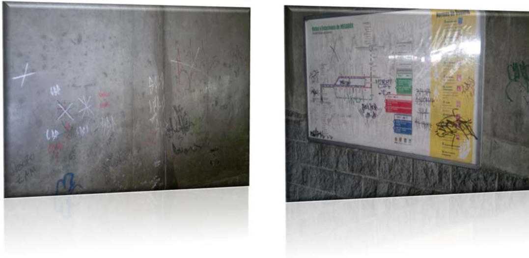
Imágenes 2, 3. Intercambiador Cuba, Fuente propia
