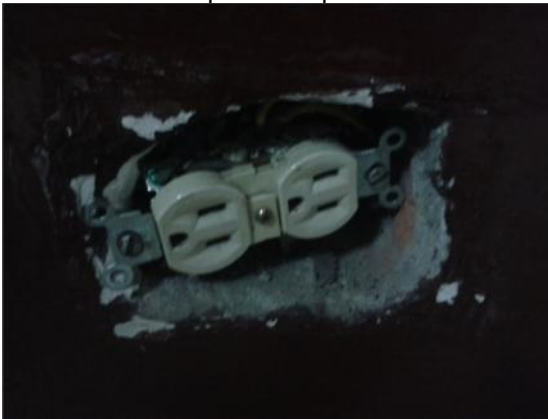
Figura 22. Caja de tomacorriente sin su respectiva tapa
