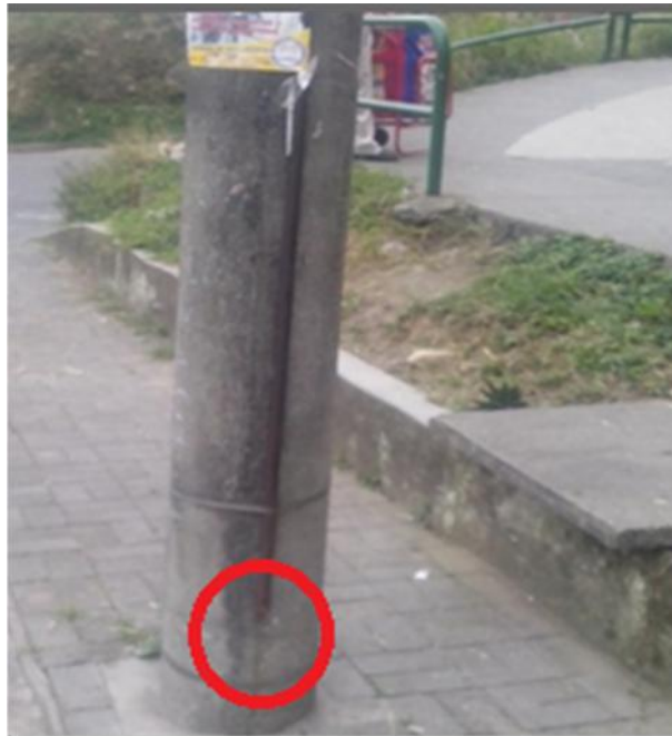
Figura 11. Puesta a tierra del transformador
