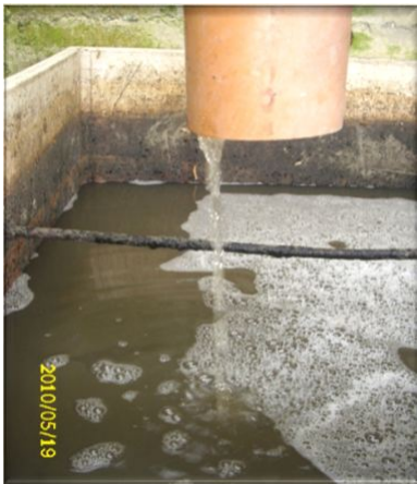
Figura 40: Salida Humedal. Primera Etapa.
