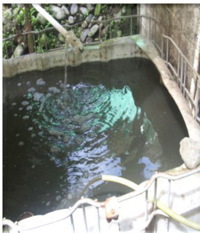
Figura 43: Tanque de dilución. Tercera Etapa.
