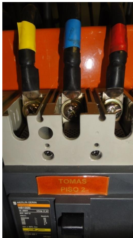
Figura 70. Totalizador de alimentación tomas piso 2
