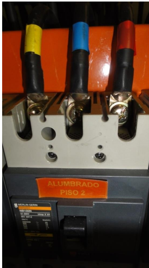
Figura 67. Totalizador de alimentación alumbrado piso 2
