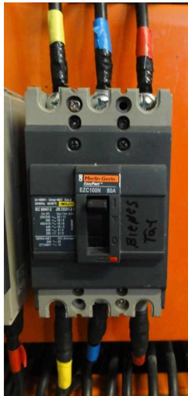
Figura 73. Totalizador de alimentación bienestar
