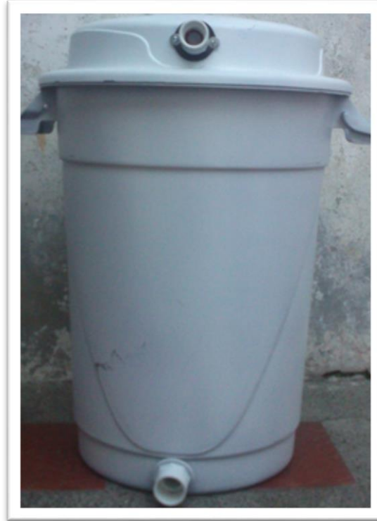
Figura 15. Tanque almacenamiento aguas recicladas.
