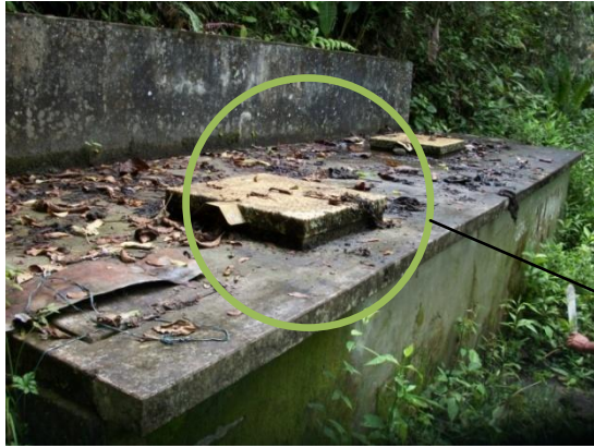
Fotografía 13: Tanque Desarenador, San Roque-La Soledad.
