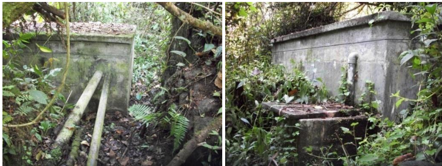
Fotografía 31: Tanque Desarenador. Acueducto Aguas Maracaibo.
