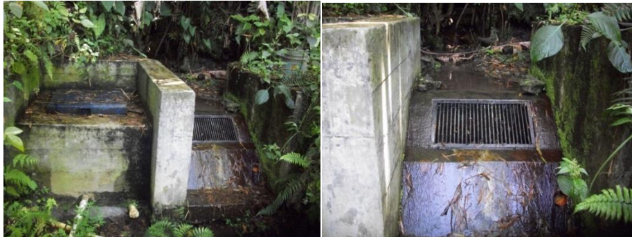
Fotografía 27: Punto de captación, Acueducto Agua Bonita.
