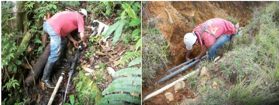
Fotografía 24: Trabajador Subcontratado por el Fontanero Realizando Labores de Reconexión a las Tuberías.
