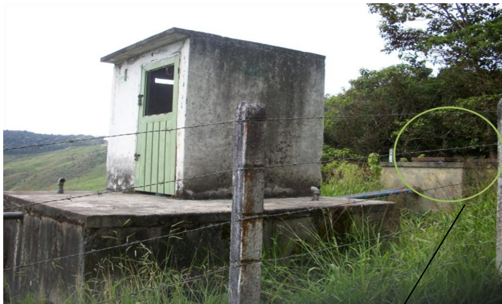
Fotografía 6: Caseta de Cloración y Tanque de Almacenamiento, San Roque-Sector Las Brisas.
